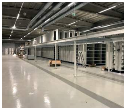
BCU-ROM chantier : montage des étagères mobiles
