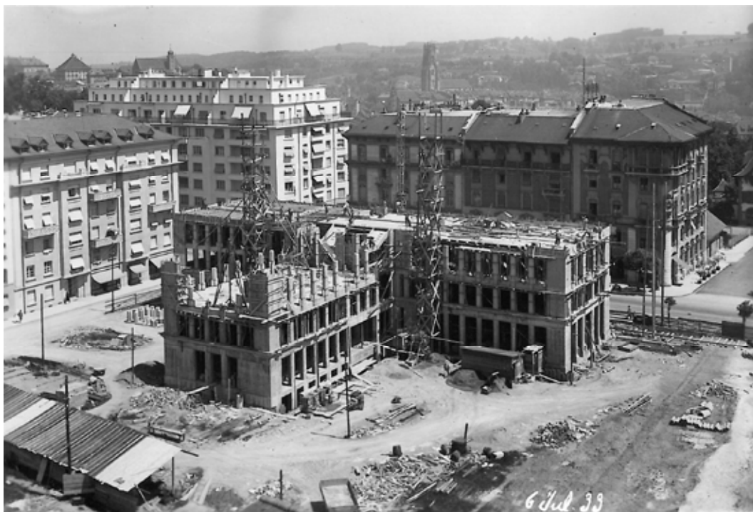
Bâtiment administratif des EEF, 1933–1934, Albert Cuony et Ernest Devolz architectes, Henri Gicot ingénieur Verwaltungsgebäude der FEW, 1933–1934, Architekten: Albert Cuony und Ernest Devolz, Ingenieur: Henri Gicot
