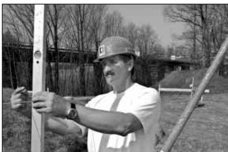
Le chantier ouvert hier à Agy fera place à un trois étoiles.
