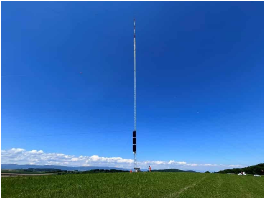
Figure 1: Vue vers le nord depuis l'emplacement du mât.
