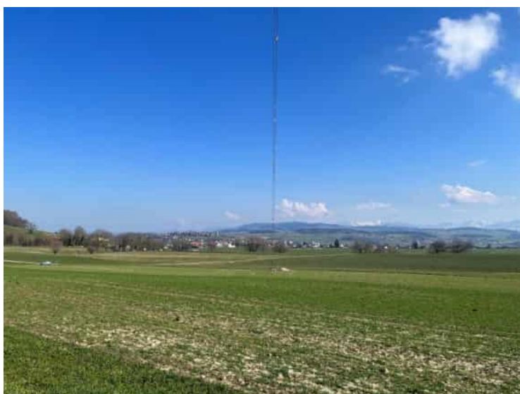
Figure 2: Vue vers l'est depuis l'emplacement du mât.
