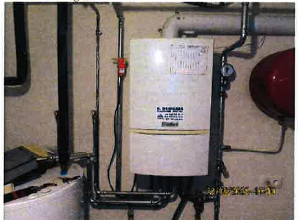
Chauffe-eau relié aux panneaux thermique
