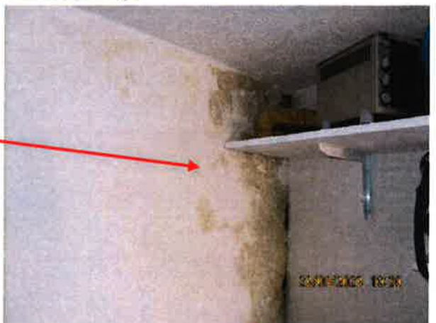
Infiltration d'eau
