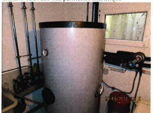
Chauffe-eau relié aux panneaux thermique
