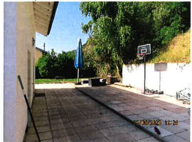
Terrasse, vue Nord-Ouest
