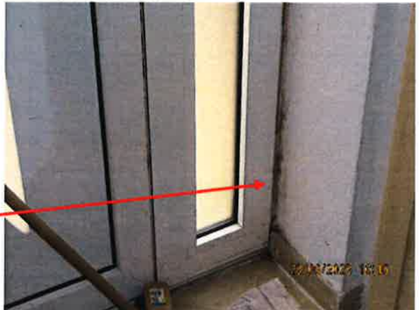
Seuil de porte ou joint de sol manquant
