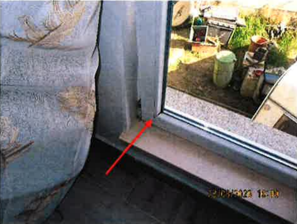
Bande serrage défectueuse au pied des façades
