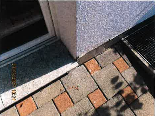
Bande serrage défectueuse au pied des façades
