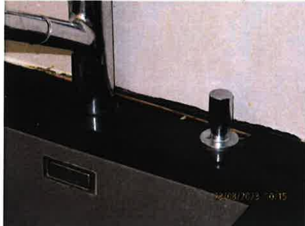
Joint souple défectueux derrière le mélangeur
