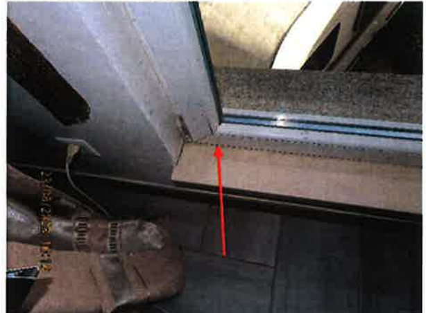
Moisissures dans le cadre, côté extérieur
