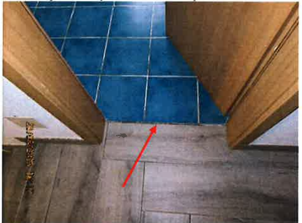
Seuil de porte ou joint de sol manquant
