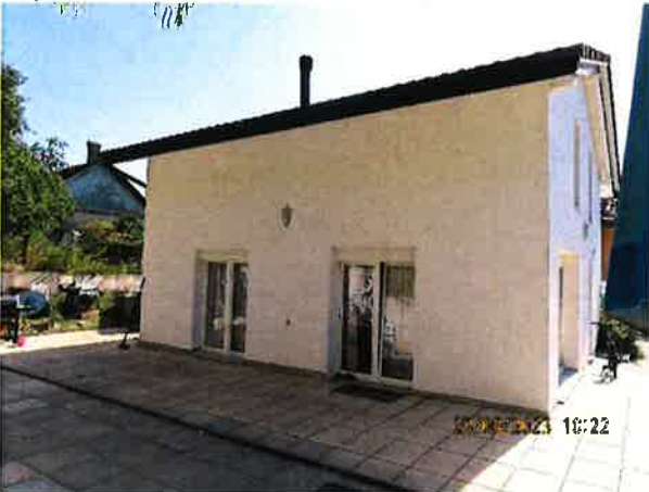
Porte d'entrée secondaire (Nord-Ouest)
