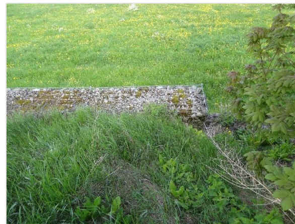
Mur de soutènement au Nord-Ouest
