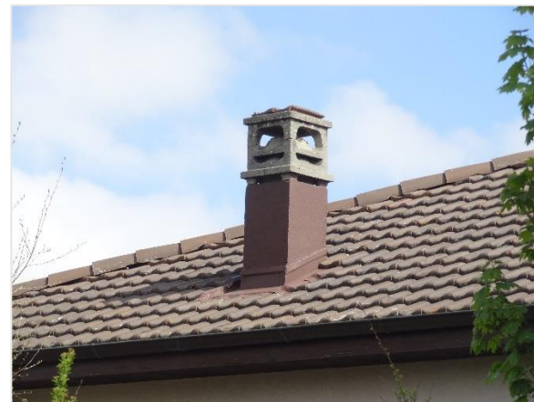
Couverture tuiles terre cuite – ferblanterie cuivre
