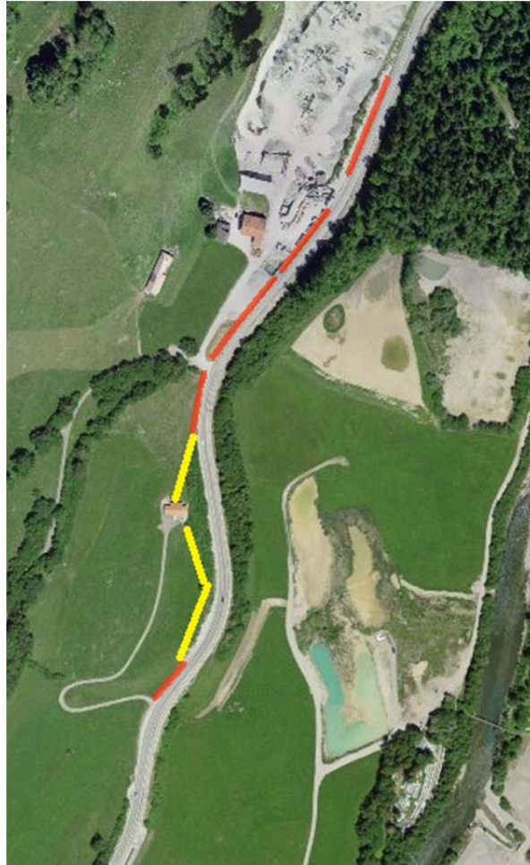
Figure 14: Barrière d'Enney 2019, en jaune le prolongement fait en 2019 (Photo aérienne : Etat de Fribourg 2017)
