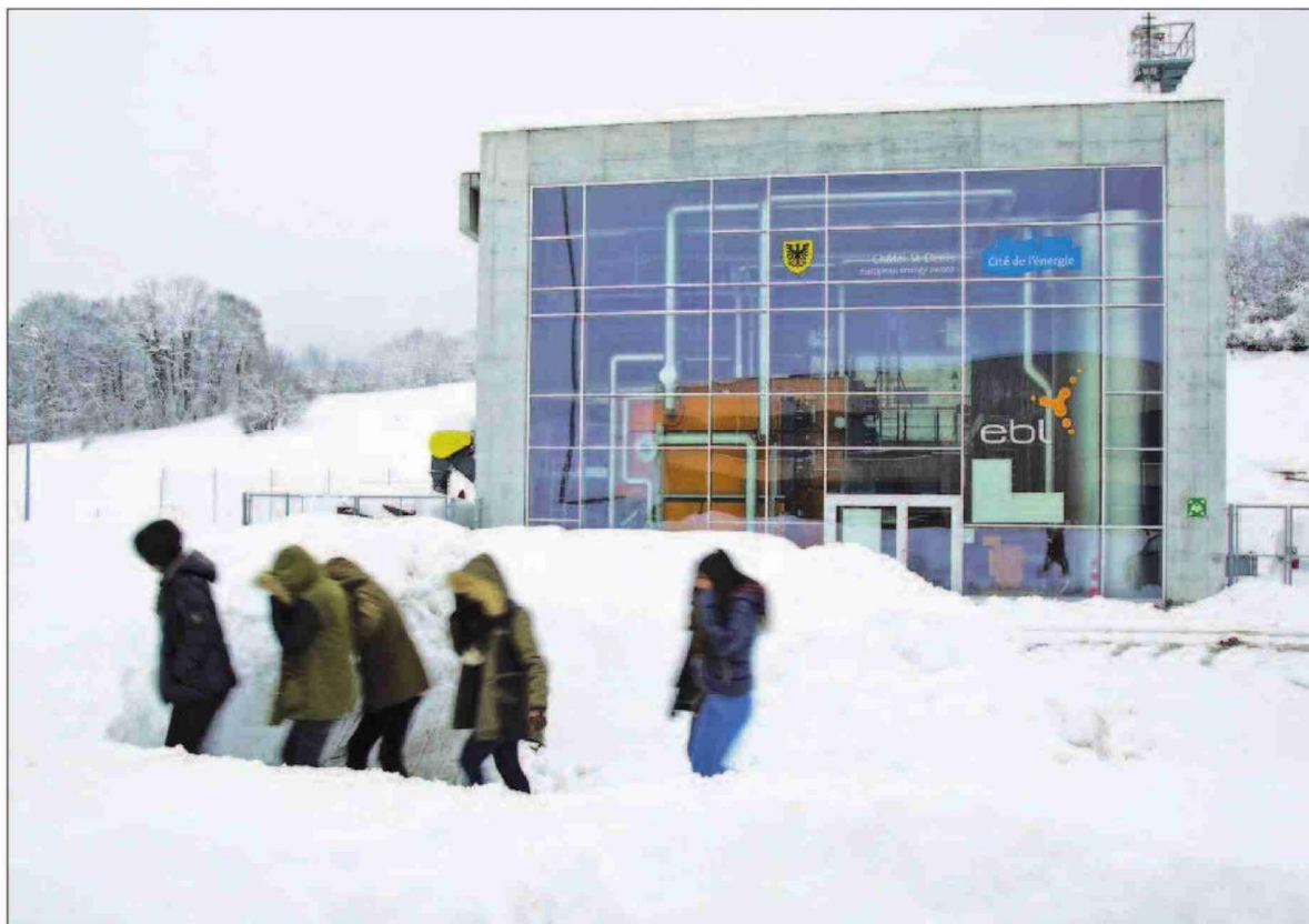
La construction d'une centrale de chauffe à bois a été déterminante pour Châtel-Saint-Denis dans l'obtention du label Cité de l'énergie. Celui-ci a depuis été renouvelé deux fois, au prix d'importants efforts. CLAUDE HAYMOZ
