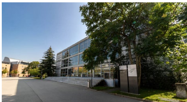
Le bâtiment PER 08 situé au chemin du Musée à Fribourg fait partie du programme prioritaire d'assainissement. © Etat FR
