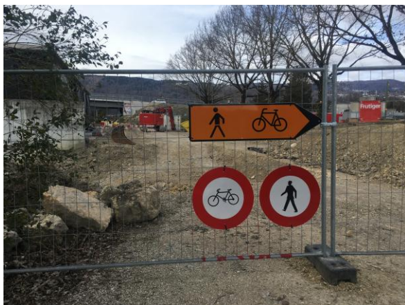
Guidage aux abords des chantiers [13]
