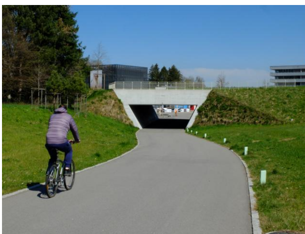
Passage inférieur sous une route cantonale [9]
