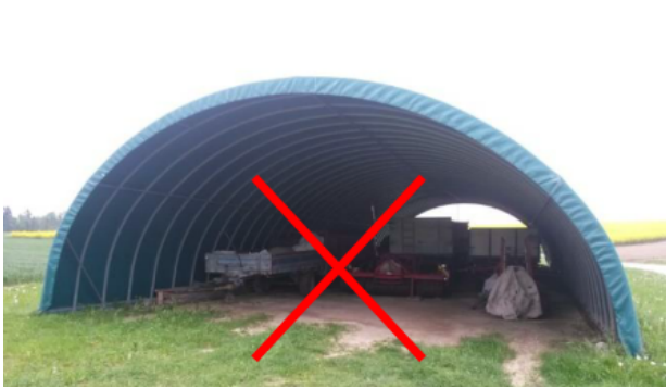
(a) Couvert pas cadastré, pas d'ancrage en béton, sol en terre.
