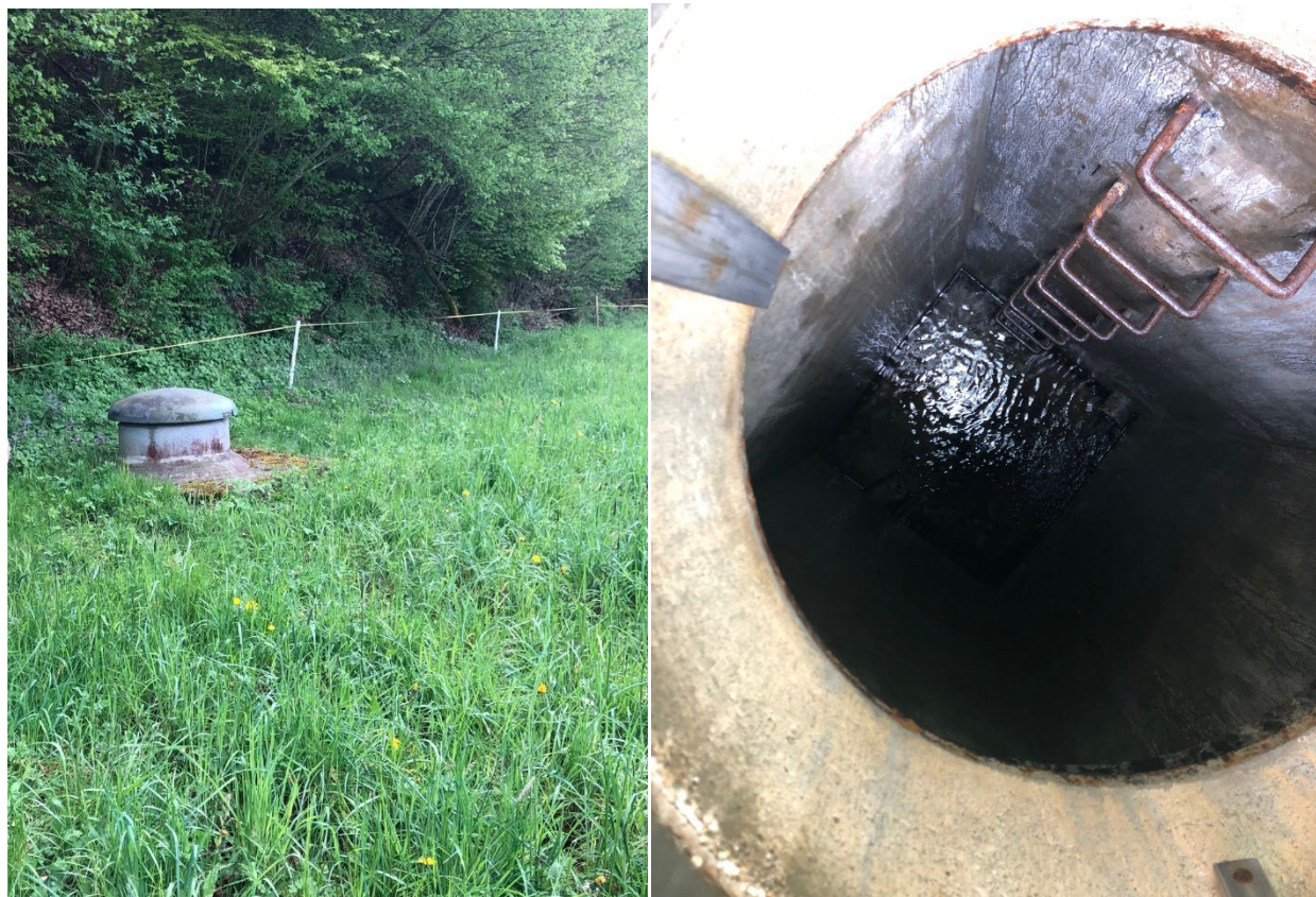
Photo 1: Chambre de captage Galmacher D
