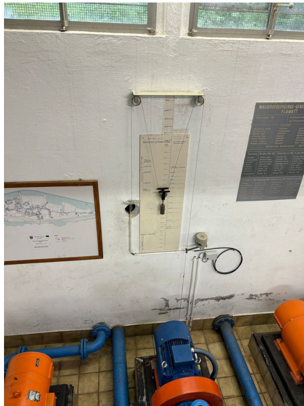
Photo 4 – Mesure de la hauteur du niveau d'eau dans le puits par flotteur.
