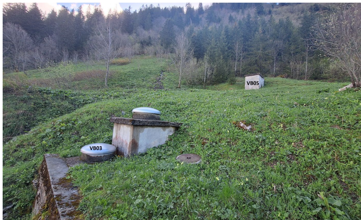
Photo 1 – Chambres de captage de Villard-Bony supérieur.
