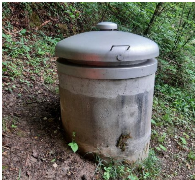
Photo 1 : Chambre de captage Vau de Praz 14
