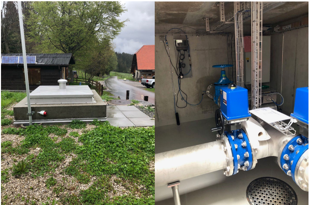
Photo 3: Chambre de traitement UV à Feyersaga
