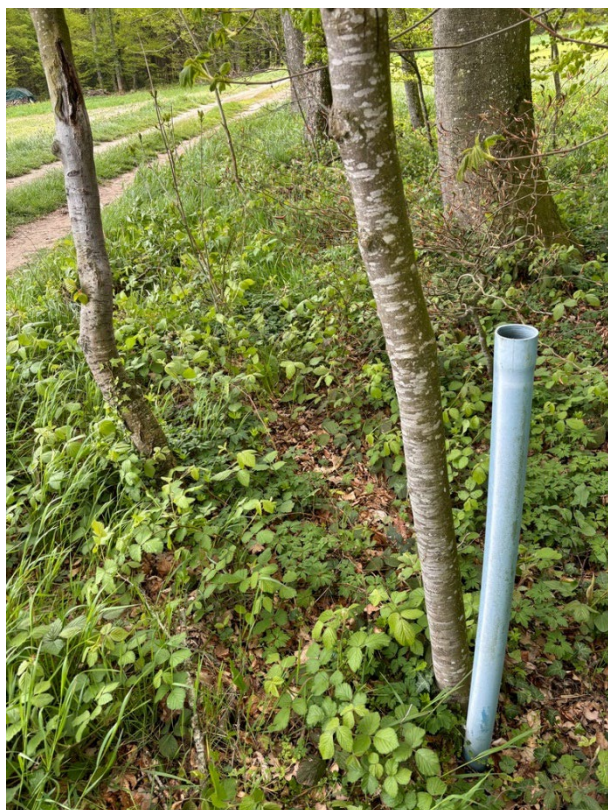
Photo 3 – Piézomètre C non protégé.
