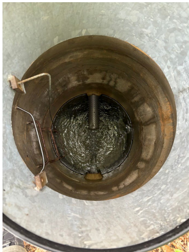
Photo 2 – Vue de la chambre n°1 avant le départ au réservoir.
