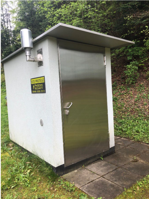
Photo 2 : Chambre de réunion des captages de la Tuffière
