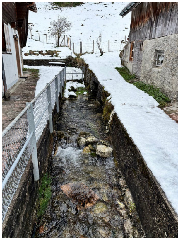
Photo 3 – Canalisation de la résurgence.
