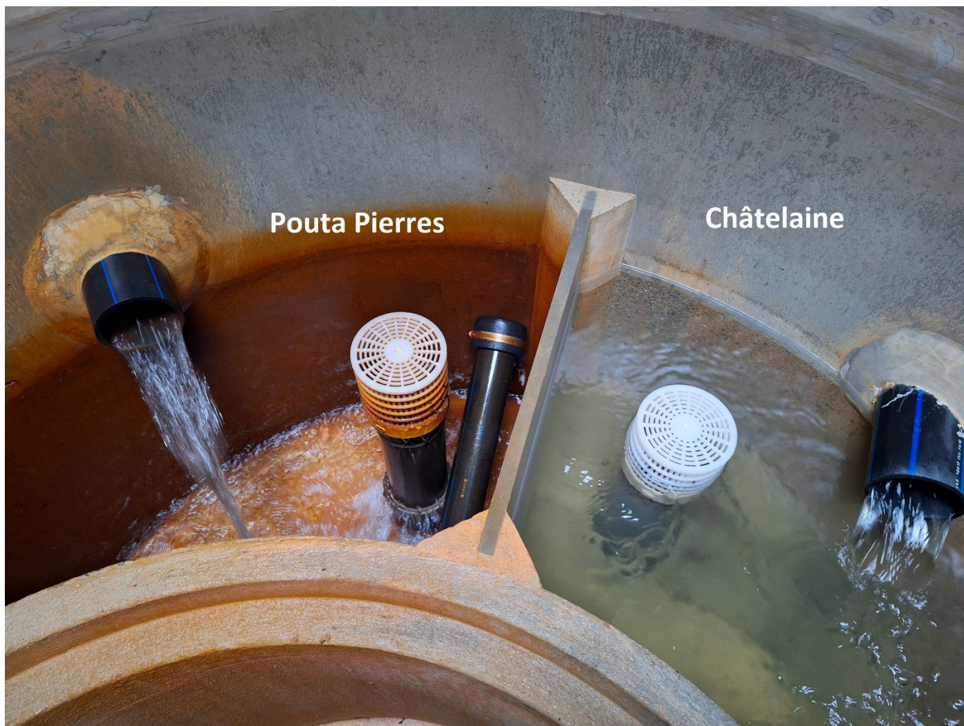
Photo 2 – Chambre de réunion Châtelaine et Pouta-Pierres (ici en décharge).
