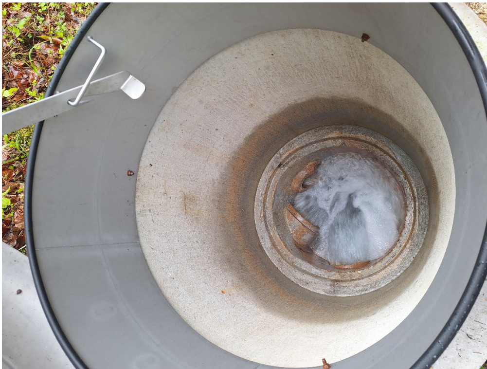
Photo 1 – Chambre de captage réceptionnant les eaux de 3 drains.
