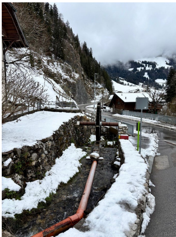
Photo 4 – Les eaux transitent sous le pont de la route cantonale pour rejoindre la Jogne.
