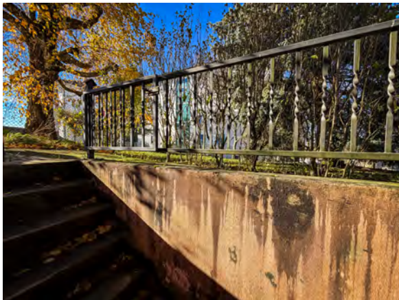
Accès au sous-sol côté Ouest
