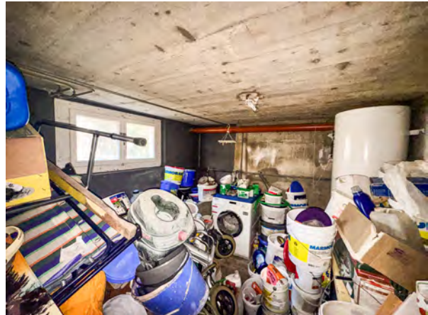
Partie gauche sous-sol avec boiler
