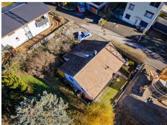
Arrière de la maison côté Sud-Ouest
