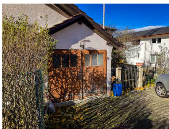
Garage et accès entrée côté Est
