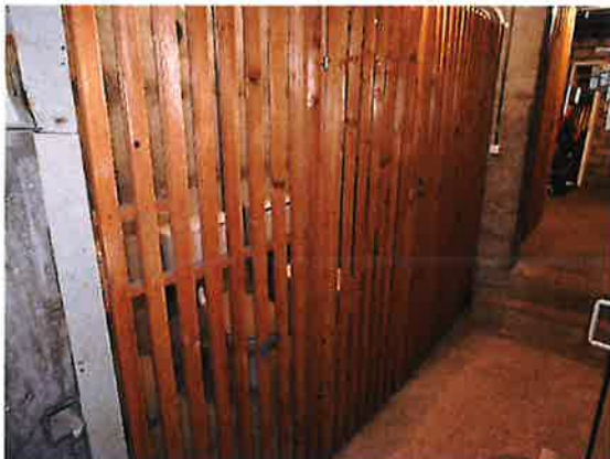
Installation sanitaire de l'abri PC
