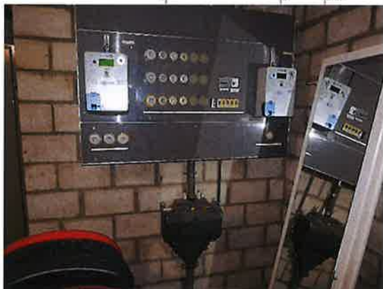
Introduction électrique et tableau principal
