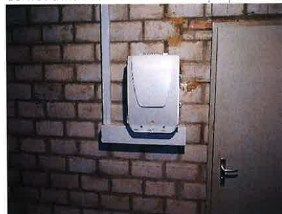
Coffret d'introduction de la fibre optique
