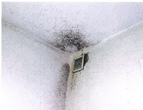
Tâches dues à l'extraction de l'air vicié de la hotte
