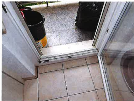
Accès au balcon depuis la cuisine
