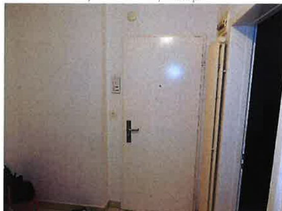
Porte d'entrée, vue du hall, interphone
