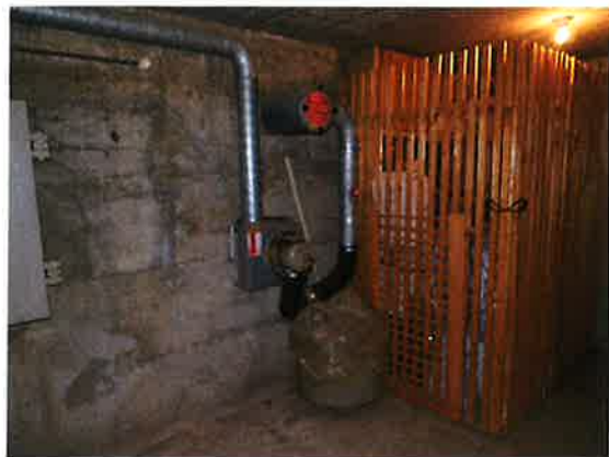
Installation de ventilation de l'abri PC
