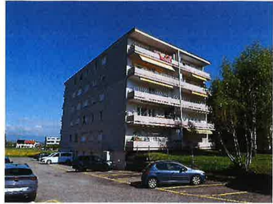
Façades Sud-Ouest et Sud-Est
