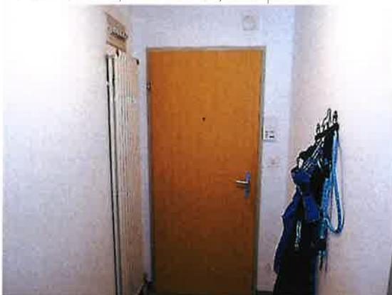
Porte d'entrée, vue du hall, interphone
