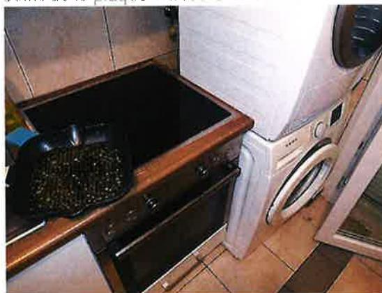
Joint de la plaque vitrocérame abîmé
