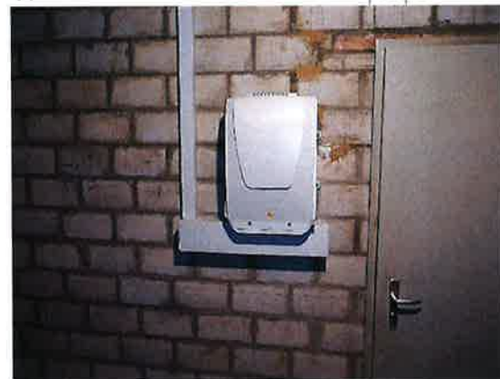
Coffret d'introduction de la fibre optique
