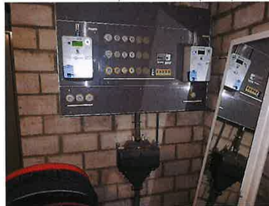
Introduction électrique et tableau principal
