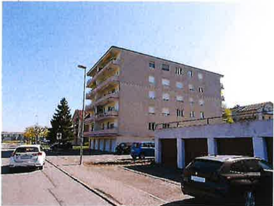
Façades Nord-Ouest et Sud-Ouest
