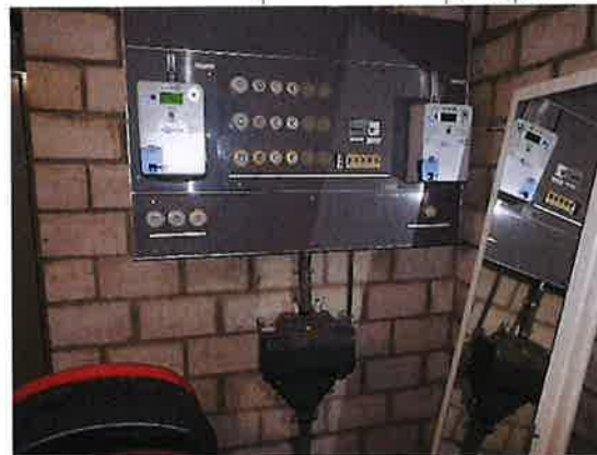
Introduction électrique et tableau principal
