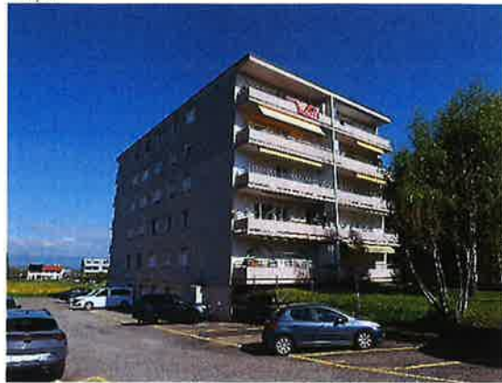
Façades Sud-Ouest et Sud-Est
