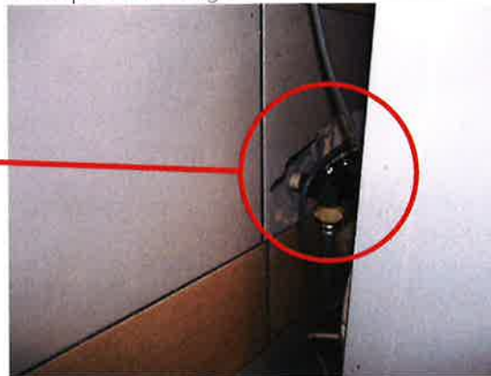
Découpe de carrelage incorrecte et visible
