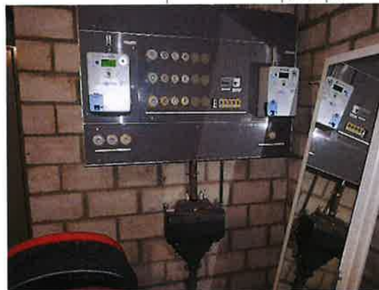
Introduction électrique et tableau principal
