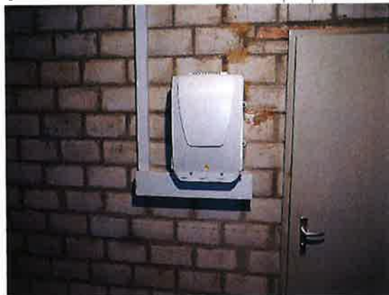
Coffret d'introduction de la fibre optique
