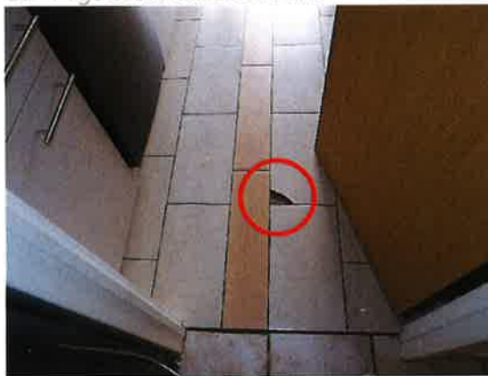
Découpe de carrelage incorrecte et visible
