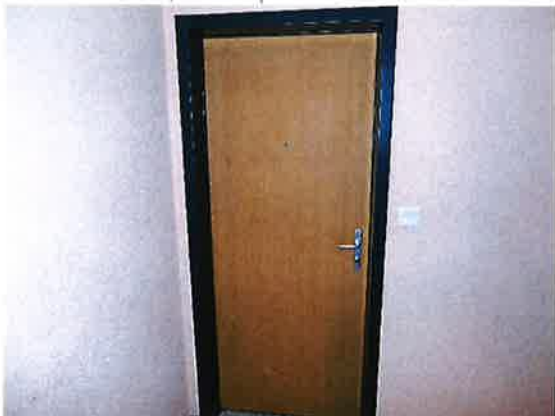
Porte d'entrée, vue depuis les communs
