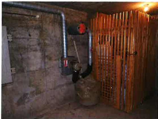
Installation de ventilation de l'abri PC
