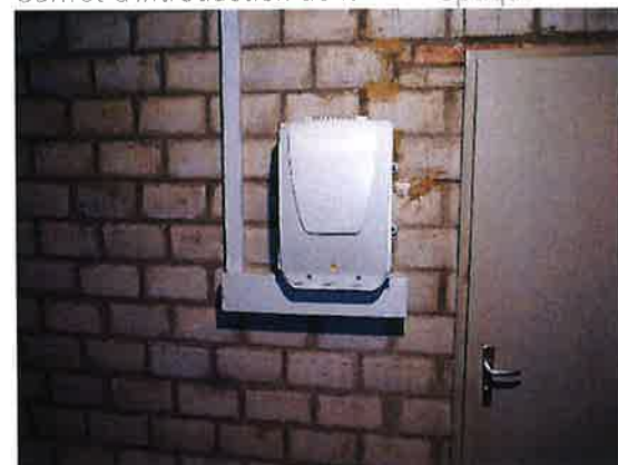
Coffret d'introduction de la fibre optique
