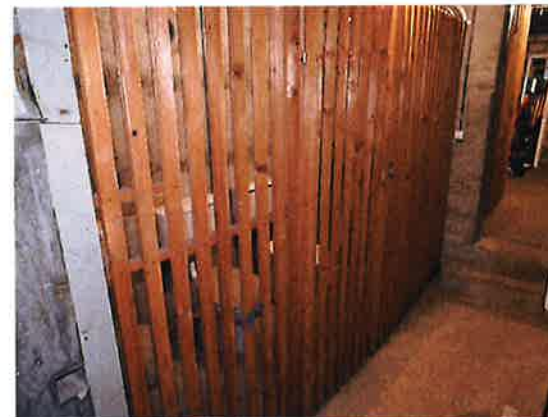
Installation sanitaire de l'abri PC
