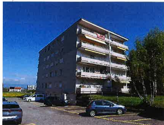
Façades Sud-Ouest et Sud-Est
