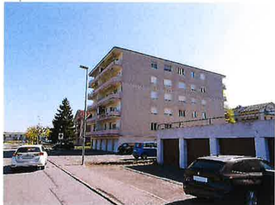
Façades Nord-Ouest et Sud-Ouest
