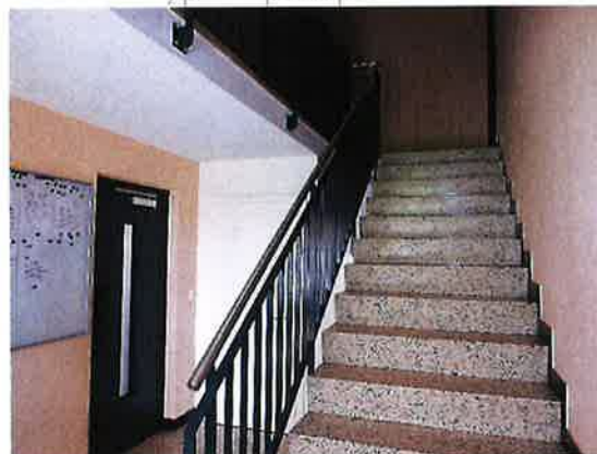
Hall d'entrée, partie publique
