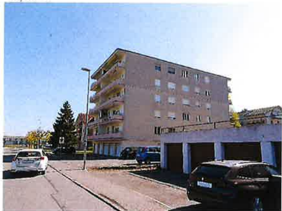
Façades Nord-Ouest et Sud-Ouest
