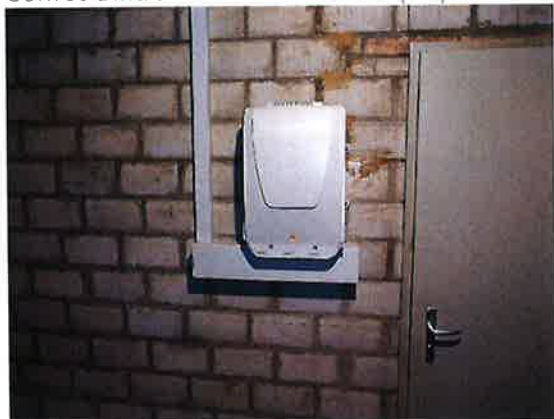
Coffret d'introduction de la fibre optique
