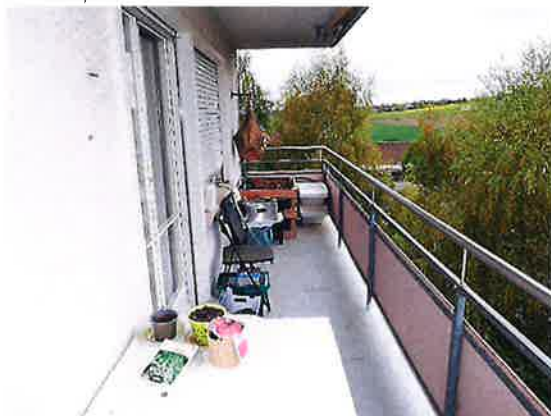
Balcon, vue Est
