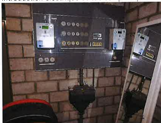
Introduction électrique et tableau principal
