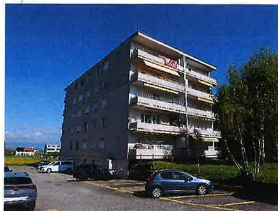
Façades Sud-Ouest et Sud-Est
