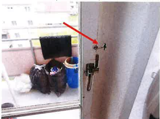
Fermeture de la porte cassée, crochet de substitut
