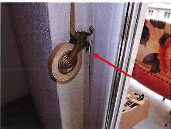
Fixation de l'enrouleur de store abîmée
