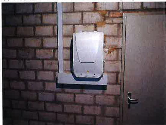
Coffret d'introduction de la fibre optique
