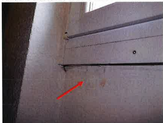
Finitions aléatoires sous le cadre fixe des fenêtres
