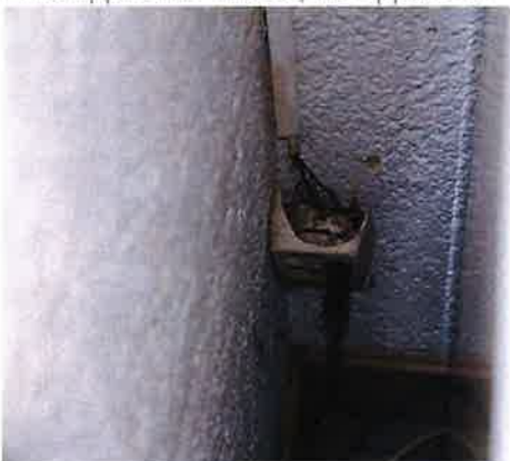
Prise apparente cassée, fils apparents
