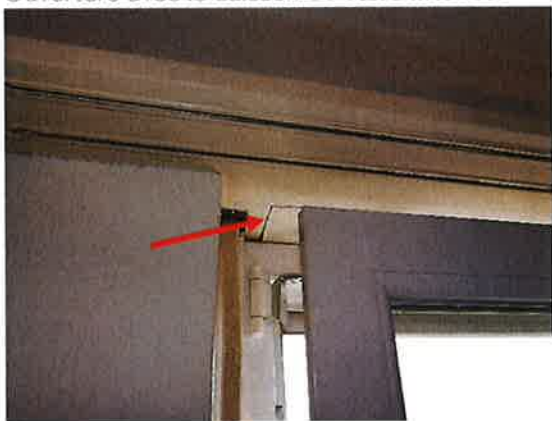
Ouverture avec le caisson de store intérieur
