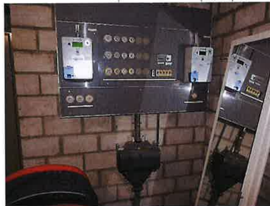
Introduction électrique et tableau principal
