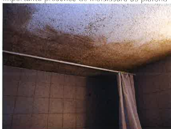
Importante présence de moisissure au plafond
