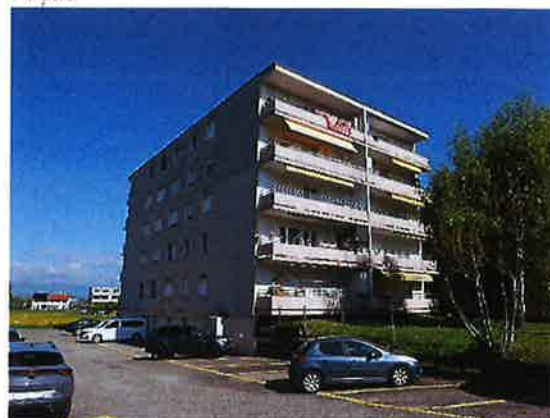
Façades Sud-Ouest et Sud-Est
