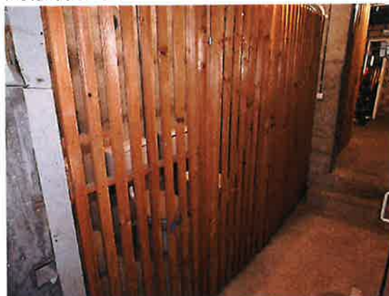
Installation sanitaire de l'abri PC
