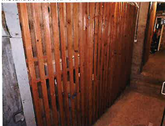
Installation sanitaire de l'abri PC
