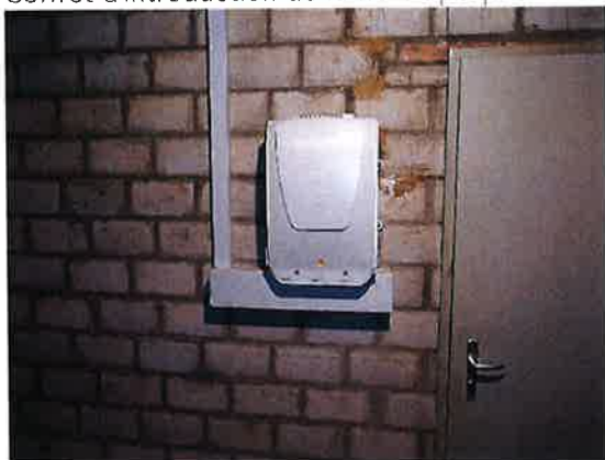
Coffret d'introduction de la fibre optique
