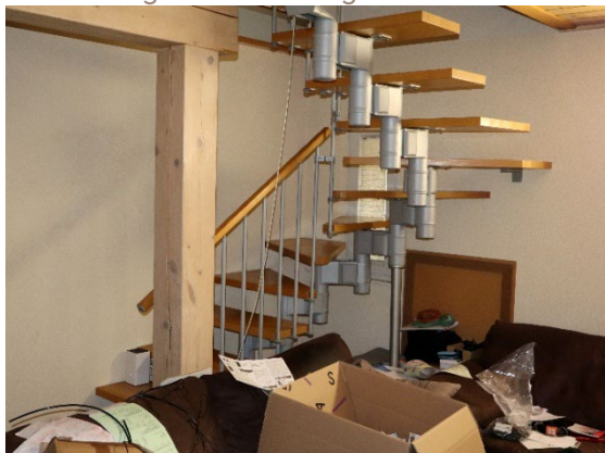
Escalier "léger" reliant l'étage
