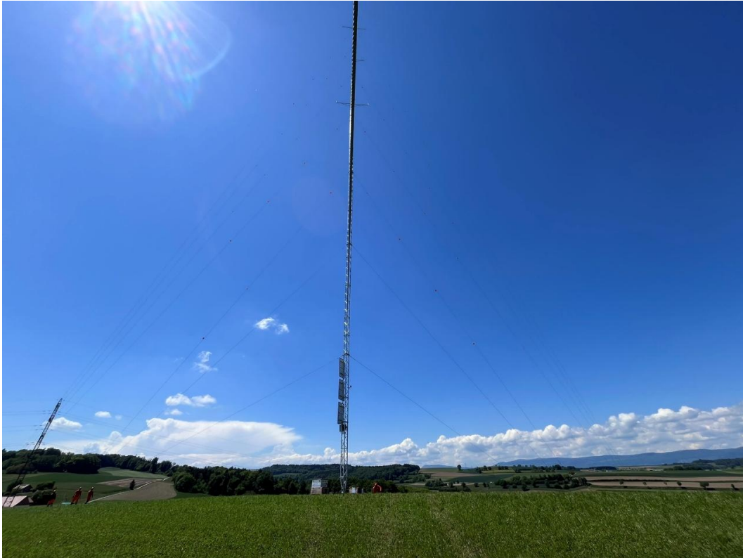
Figure 4: Vue vers l'ouest depuis l'emplacement du mât.
