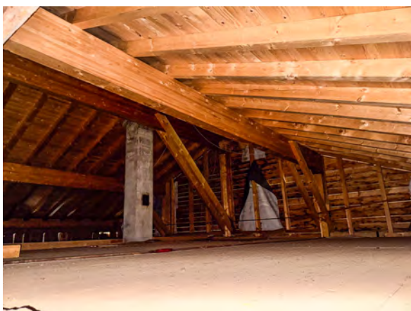
Galetas ou stockage sous toiture partie habitation
