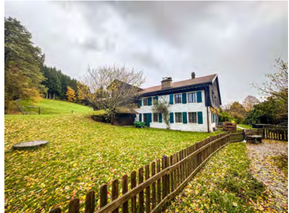
Façade Sud-Ouest depuis l'étang
