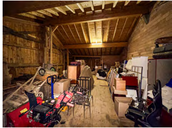
Fenil et porte menant au pont côté Sud-Ouest
