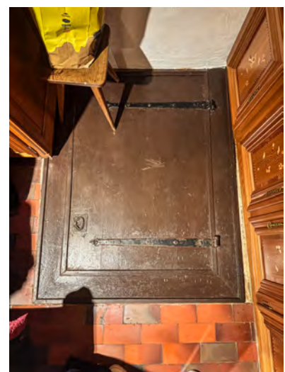
Trappe d'accès à une des caves depuis la cuisine
