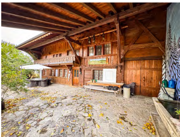
Façade principale, entrée habitation et rural, Est
