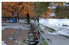
La crue de la Sarine de novembre 2023 a provoqué des dommages, notamment en Basse-Ville de Fribourg. Source: SEn.
