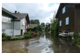
La montée des eaux des lacs du pied du Jura a provoqué des inondations et des dégâts en juillet 2021, notamment à Estavayer-le-Lac. Source: SEn.
