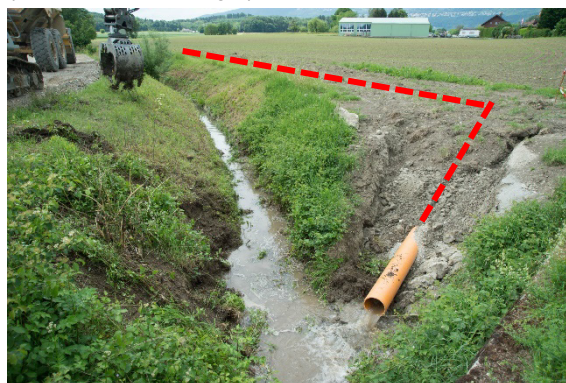
Fig. 27d : Déversement du collecteur dans l'Orpundbach. Il ne doit pas y avoir de barrage de castor en aval du déversement. (photo : Christof Angst)
