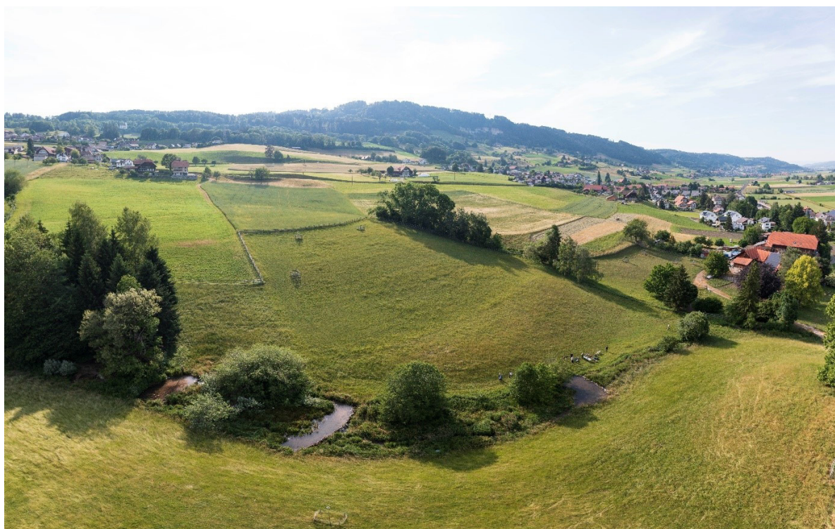
Fig. 26 : Plusieurs Beaver Dam Analogs sur un petit ruisseau auparavant fortement incisé à Kaufdorf (BE). Avant la construction des BDA, le ruisseau d'origine ressemblait à la portion située en aval du dernier BDA, à droite de l'image. Plus d'informations sur le projet : voir Minnig et al. (2024b) (photo: Christof Angst).
