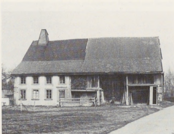
Bossonnens 29 (1827). Ferme veveysanne, construction mixte. Bauernhaus des Vivisbachbezirks, in Gemischtbauweise.
