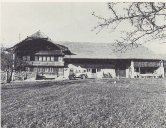
Vaulruz 81 (début 18 e s.). Ferme du plateau, en bois, à pignon transversal. Mittelländischer Bauernhaustyp aus Holz, mit Quergiebel.
