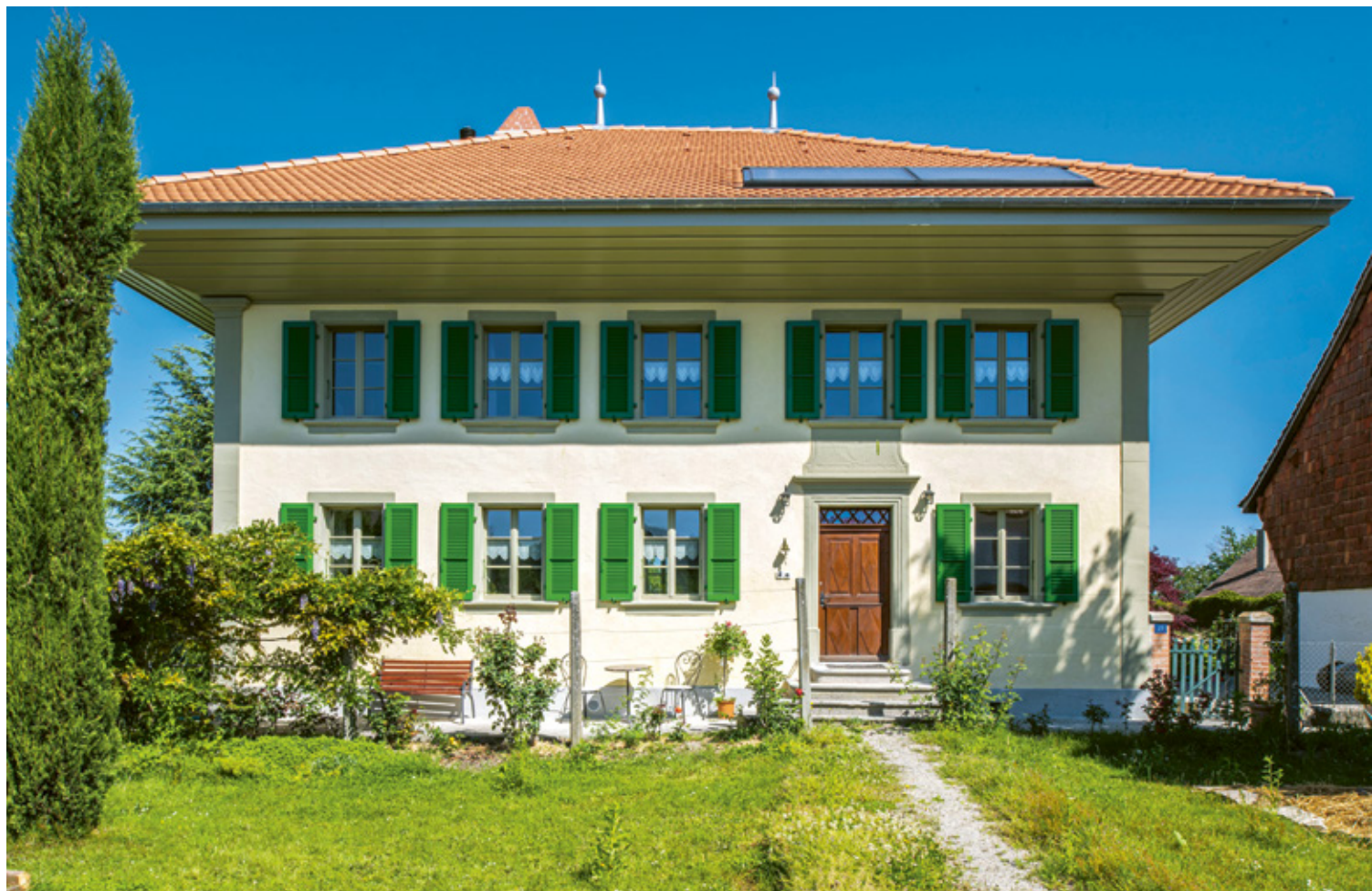
Villarepos, maison protégée en catégorie 2, dont les façades ont reçu un crépi isolant Haga Biotherm. Atelier d'architecture espaces & environnement
