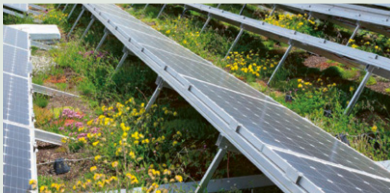
Végétation et panneaux solaires font bon ménage. Cette combinaison améliore la performance énergétique en évitant les surchauffes.
