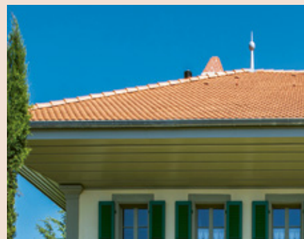
Rive le long des gouttières, appelée larmier.
