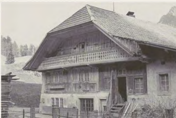
383 Le Moulin d'en haut (n° 2) de 1726. Construction en bois; les parties en dur contenaient les locaux du moulin.
