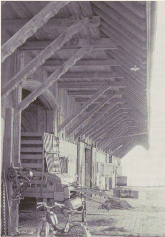
211 Grange datée de 1935 L'avant-toit est étayé par une trentaine de bras sculptés.
