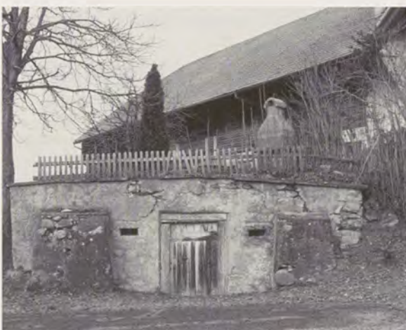
302 Der eingetieft und gewölbte Kabiskeller Er trägt anstelle des Daches eine Abdeckung mit Erdmatten und Steinplatten.
