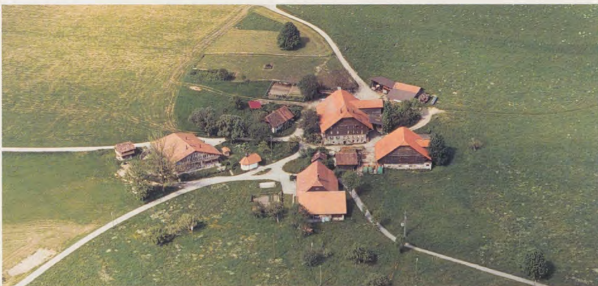
336 Luftaufnahme 1999, von Osten
