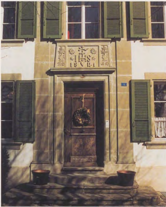
323 Eingangspartie des Wohnhauses Nr. 1 mit signiertem Sandsteinrelief (Supraporte)
