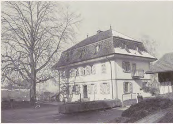
329 Haus Nr. 1 Bürgerlicher Wohnstock des ausgehenden 18. Jh., auf älterem Kellersockel, mit zeittypischem Mansarddach.
