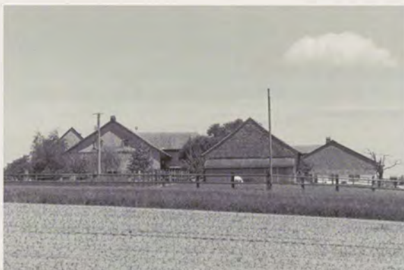
179 Silhouette vue de l'ouest Orientation parallèle des faîtes. Pignons exposés aux intempéries, protégés par la tuile, le tavillon et l'éternit. La pente devient plus raide dans le courant du XIX e siècle (époques de construction de gauche à droite: 1836, 1808, 1873, fin XVIII e siècle).
