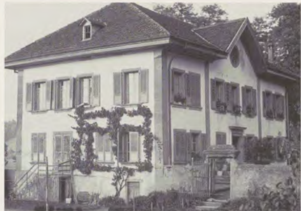
232 Herrenhaus von 1846 Längsfassade und Quergiebel über Mittelteil.
