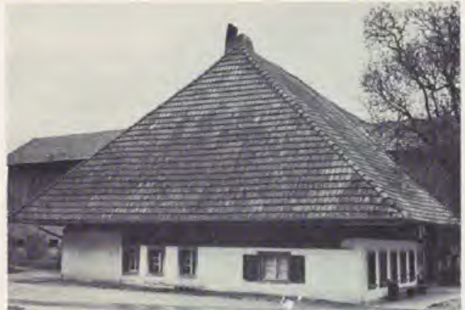
862 Alter Mauerteil links
