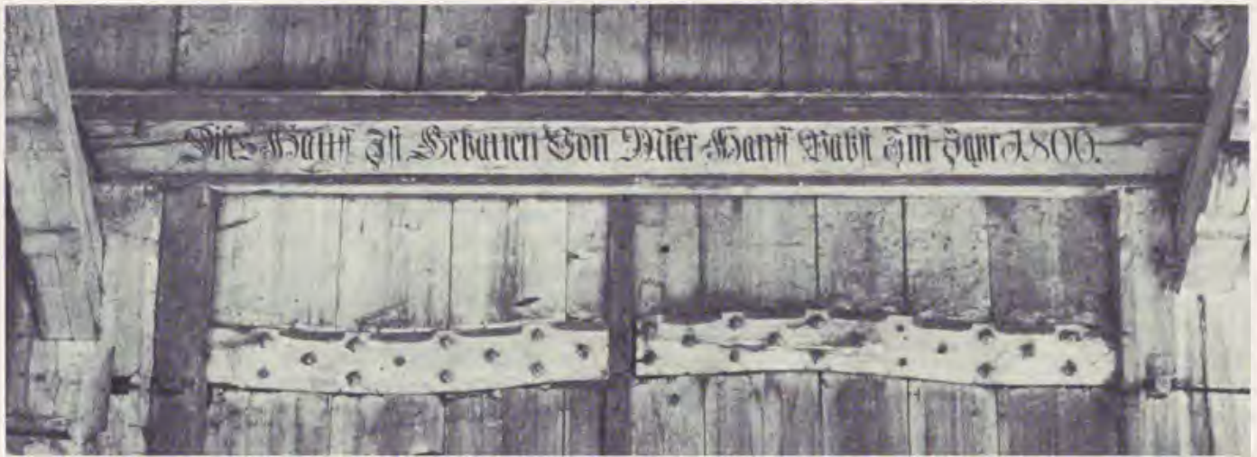
113 Plasselb 48 (1800) Tennsturzinschrift: «Dieses Hauss Ist Gebauen Von Mier Hans Pabst Im Jahr 1800»
