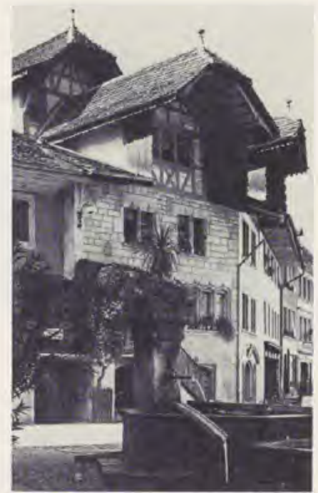
633 Murten, Rübenloch (16. Jh.) Quergie- belbögen Arcs de pignon (dat. 1672)
