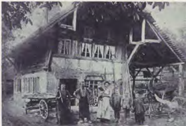
941 Ansicht von Südwesten (Photo um 1900)
