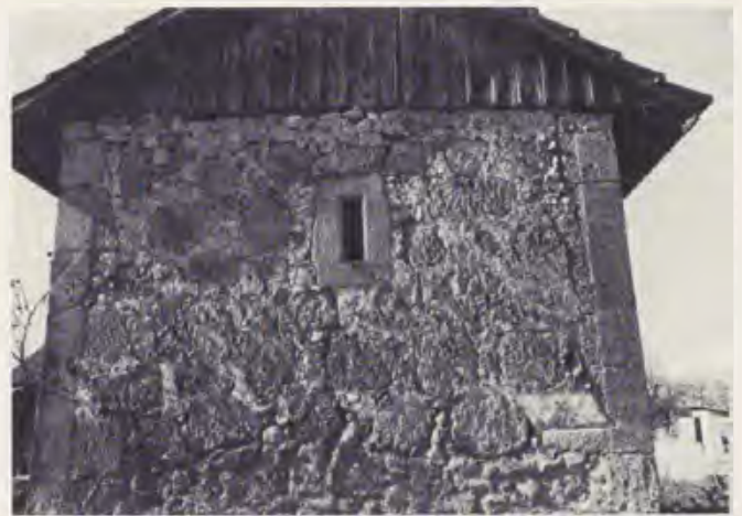
842 Mur pignon sud-est
