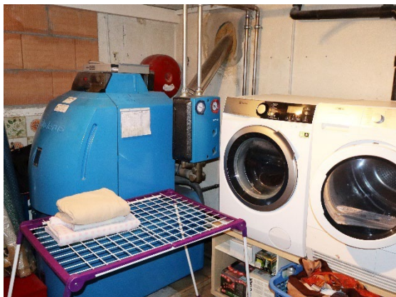
Chaudière combinée à mazout
