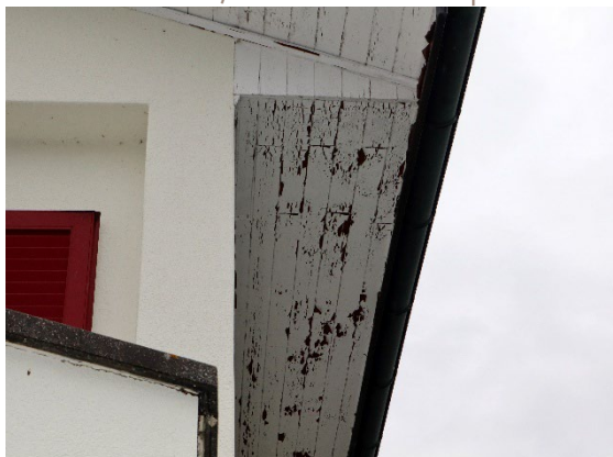
Avant-toit abîmé, décollement de la peinture
