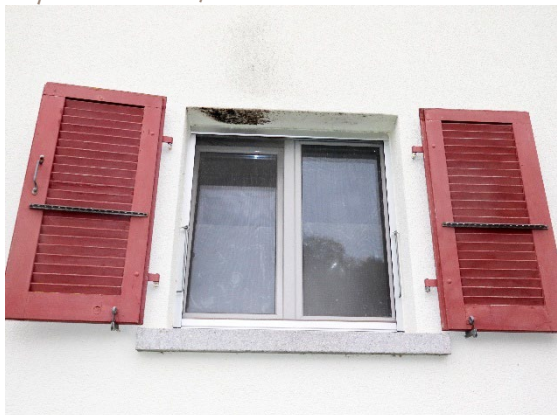
Façade Nord-Est, moisissure sur la couverte
