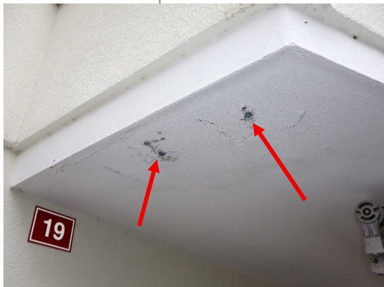
Décollement du crépi sous le balcon
