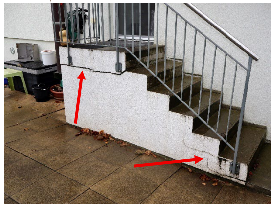
Fissures, tassement différentiel de la fondation
