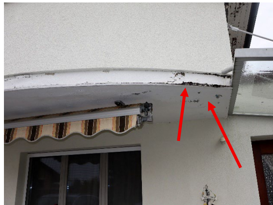
Fissures, tassement différentiel de la fondation
