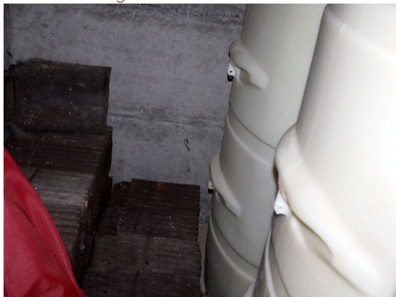
Pas de cuvelage étanche dans le local citerne
