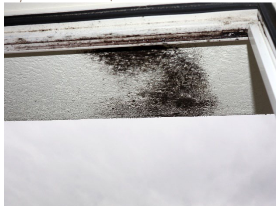
Façade Sud-Ouest, moisissure sur la couverte
