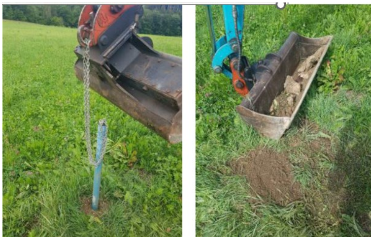
Retrait d'un tube et comblement de l'avant-trou
