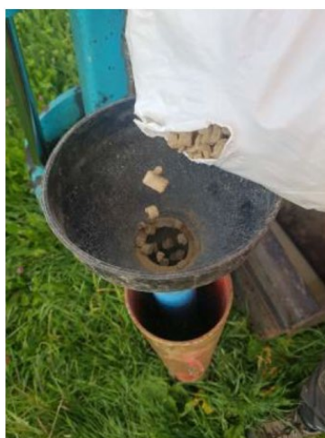
Exemple de remplissage d'un tube avec de la bentonite
