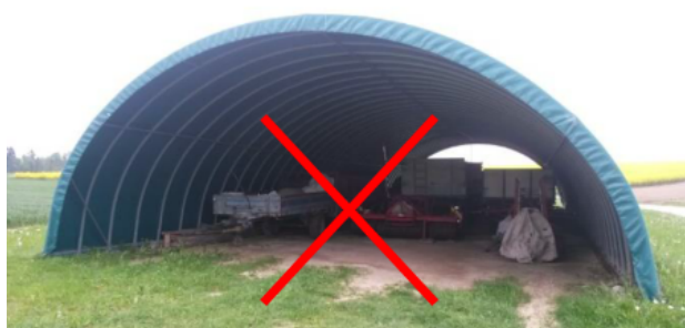
(a) Couvert pas cadastré, pas d'ancrage en béton, sol en terre.
