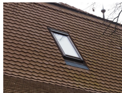
Exécution idéale d'une fenêtre de toit grâce à l'affleurement parfaitement soigné au niveau des tuiles.
