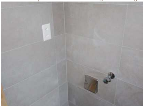
Connexions pour colonne de lavage et séchage
