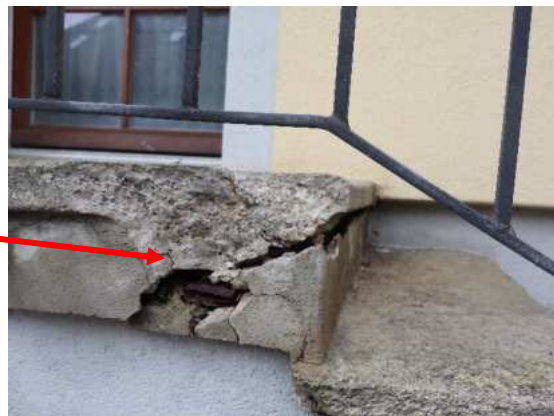
Mise à nu des fers et carbonatation
