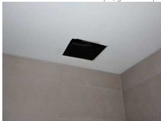
Bouche de ventilation mécanique, grille manquante
