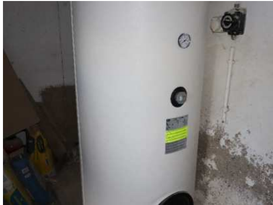
Boiler d'eau chaude sanitaire de 300 litres
