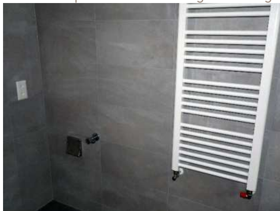
Connexions pour colonne de lavage et séchage
