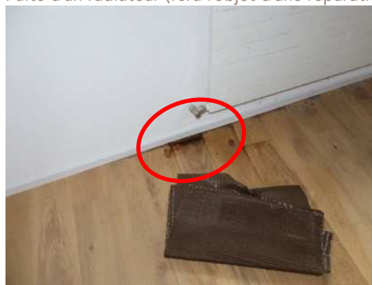
Fuite d'un radiateur (fera l'objet d'une réparation)
