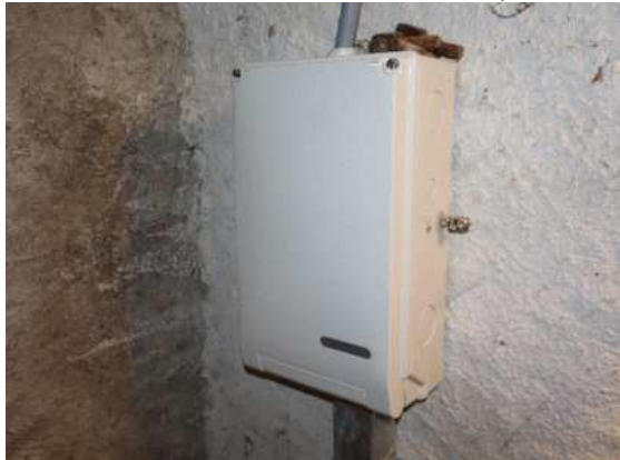
Nouveau coffret d'introduction électrique
