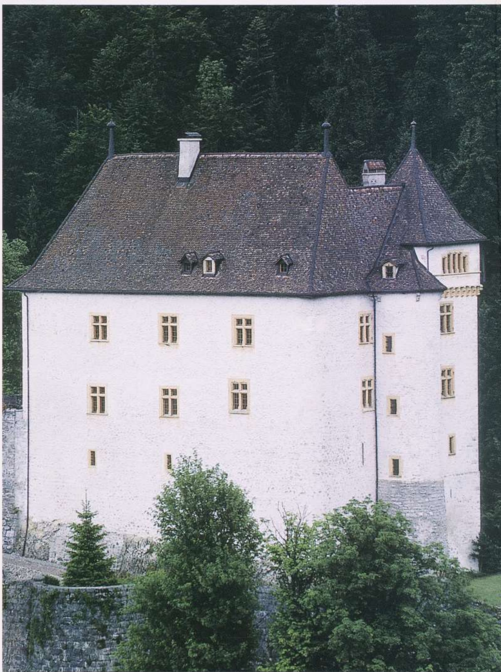
Sur ces façades, le crépi à la chaux datant de 1750 est encore en place.
