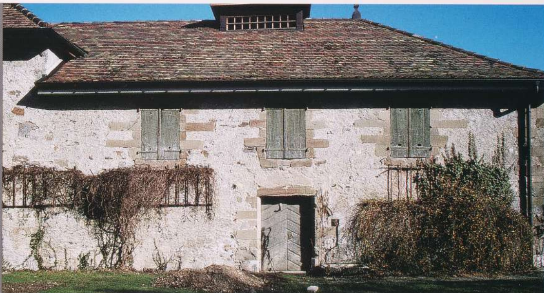
Façade d'un bâtiment rural du XIX e siècle avec son crépi d'origine presque intégralement conservé.
