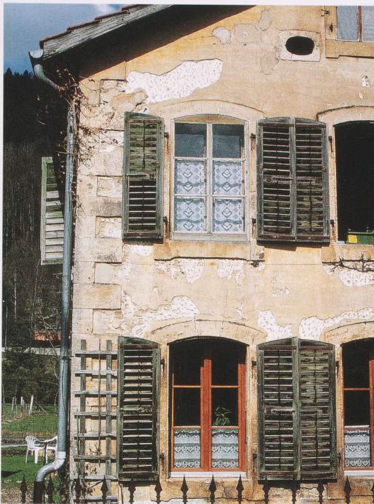
Les crépis d'origine et leurs badigeons apparaissent sous le crépi plus récent.
