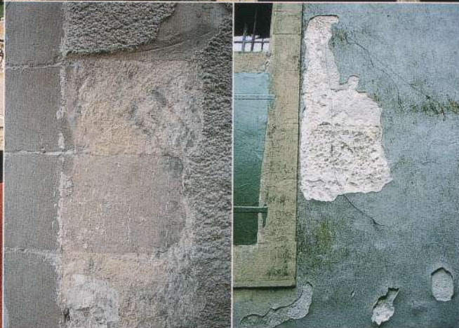
Les crépis d'origine et leurs badigeons apparaissent sous le crépi plus récent.
