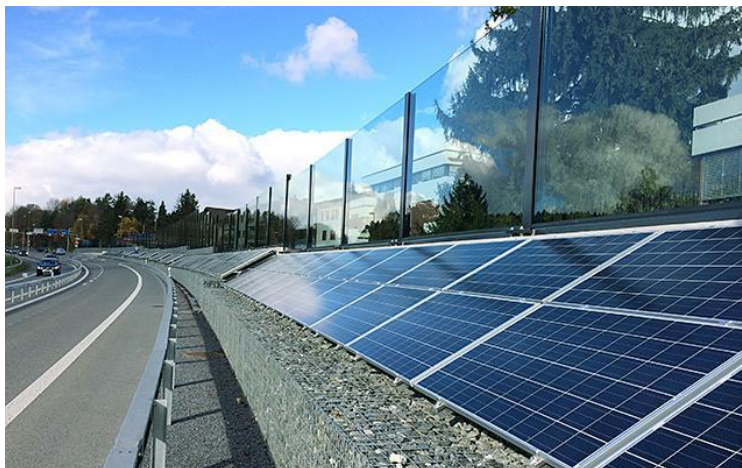
Illustration 7 : L'installation photovoltaïque de 89 kW a été réalisée en 2014 à Zumikon (ZH) sur une bande longue de 300 m entre le mur antibruit et l'autoroute accessible et protégée par une glissière de sécurité. 12
