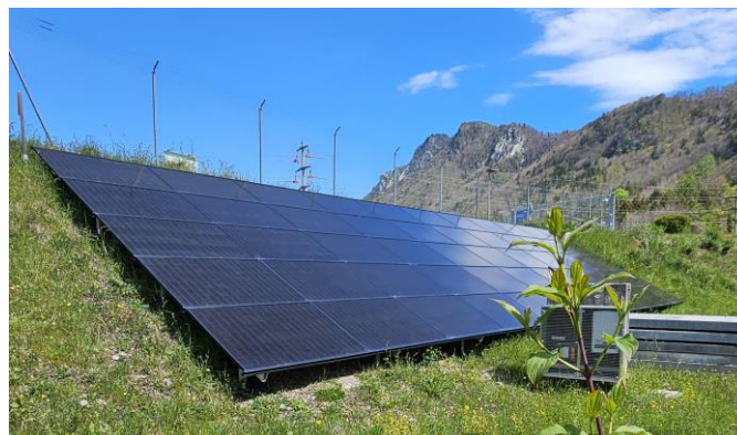
Illustrations 1 et 2 : Modules montés sur les talus du site de la STEP Guggersbach à Planfayon (FR) et de la centrale électrique Electrobroc à Broc (FR). Source : NET SA
