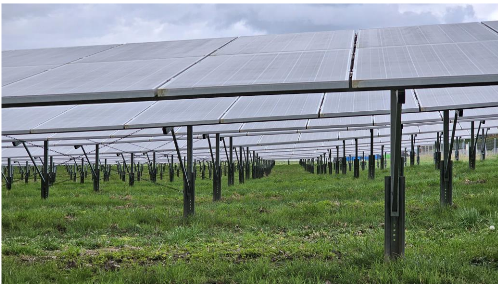
Illustration 6 : Système de montage et fondations du système photovoltaïque en zone industrielle à Payerne (VD). Source : NET SA
