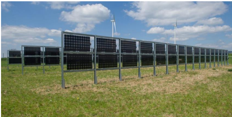
Illustration 4 : Modules bifaciaux intégrés dans une installation photovoltaïque verticale. 10
