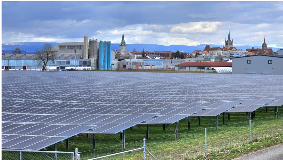
Illustration 3 : Modules standards montés en zone industrielle à Payerne (VD) avec une inclinaison de 11,5°. Source : NET SA
