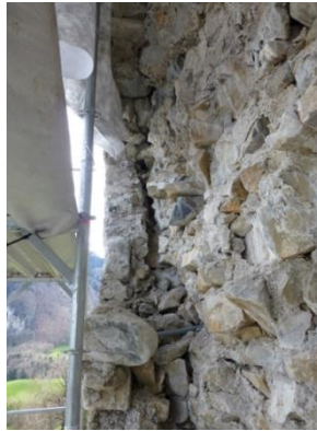
Figure 2 Mur Nord - Décollement du parement
