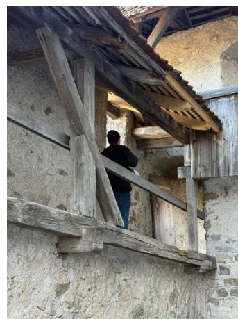
Figure 4 Chemin de ronde - Réparation d'urgence charpente
