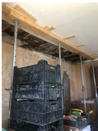
Figure 5 Tour carrée - Etayage provisoire du plancher
