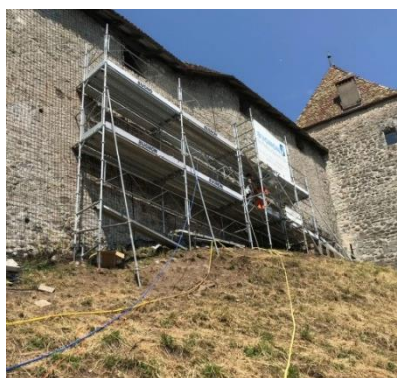
Figure 10 Mise en œuvre par « micro-clouage »
