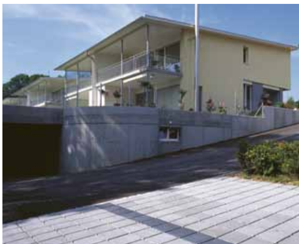
Illustration 21: Surface de parking avec pavés écologiques CARENA® Gravier
