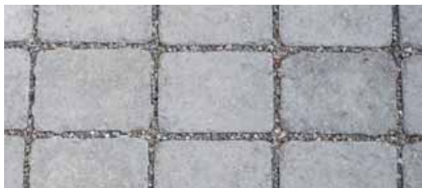
Illustration 12: Pavés écologiques à joints élargis correctement formés
