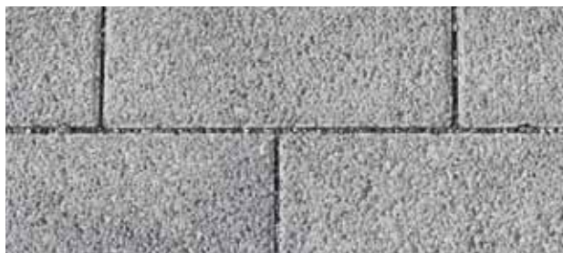
Illustration 11: Pavage filtrant efficace grâce à un jointoiment correct
