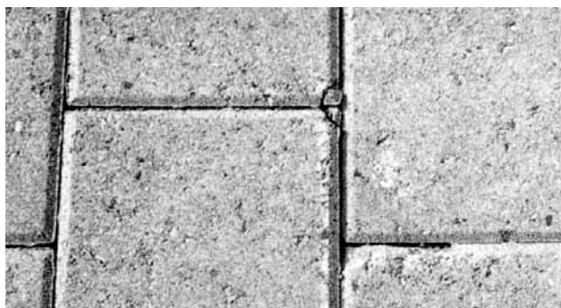
Illustration 6: Eclatement des arêtes dû à l'absence de jointoiment
