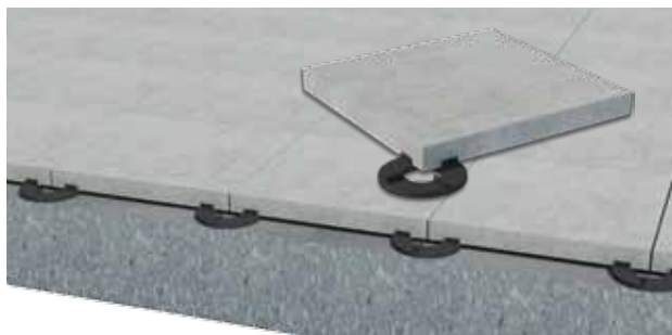
Figure 37: Dalles posées sur une construction en béton rigide avec anneaux d'appui
