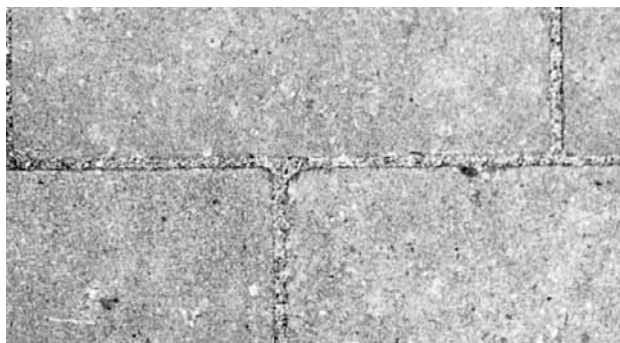
Illustration 5: Pavage efficace grâce à un jointoiment correct
