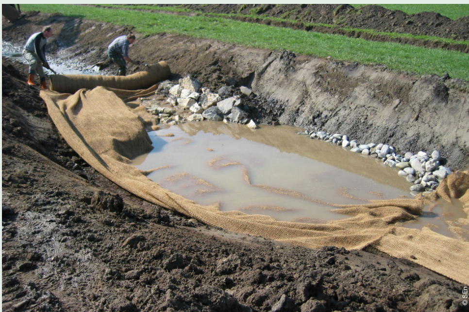
Mise en place de la natte de coco servant de base au lit du cours d'eau.
