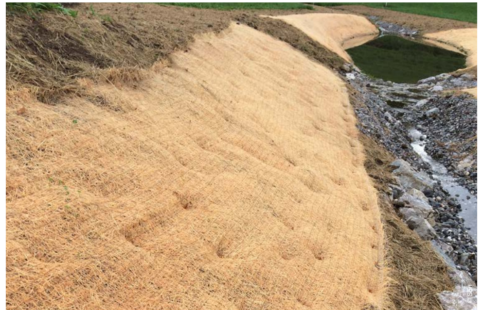
Test de mise en place d'un tapis anti-érosion en laine de bois, une alternative à la natte de coco.
