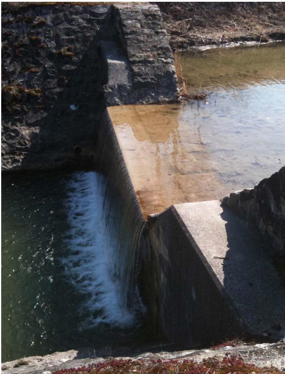
Le seuil infranchissable pour les poissons en amont de la route cantonale.
