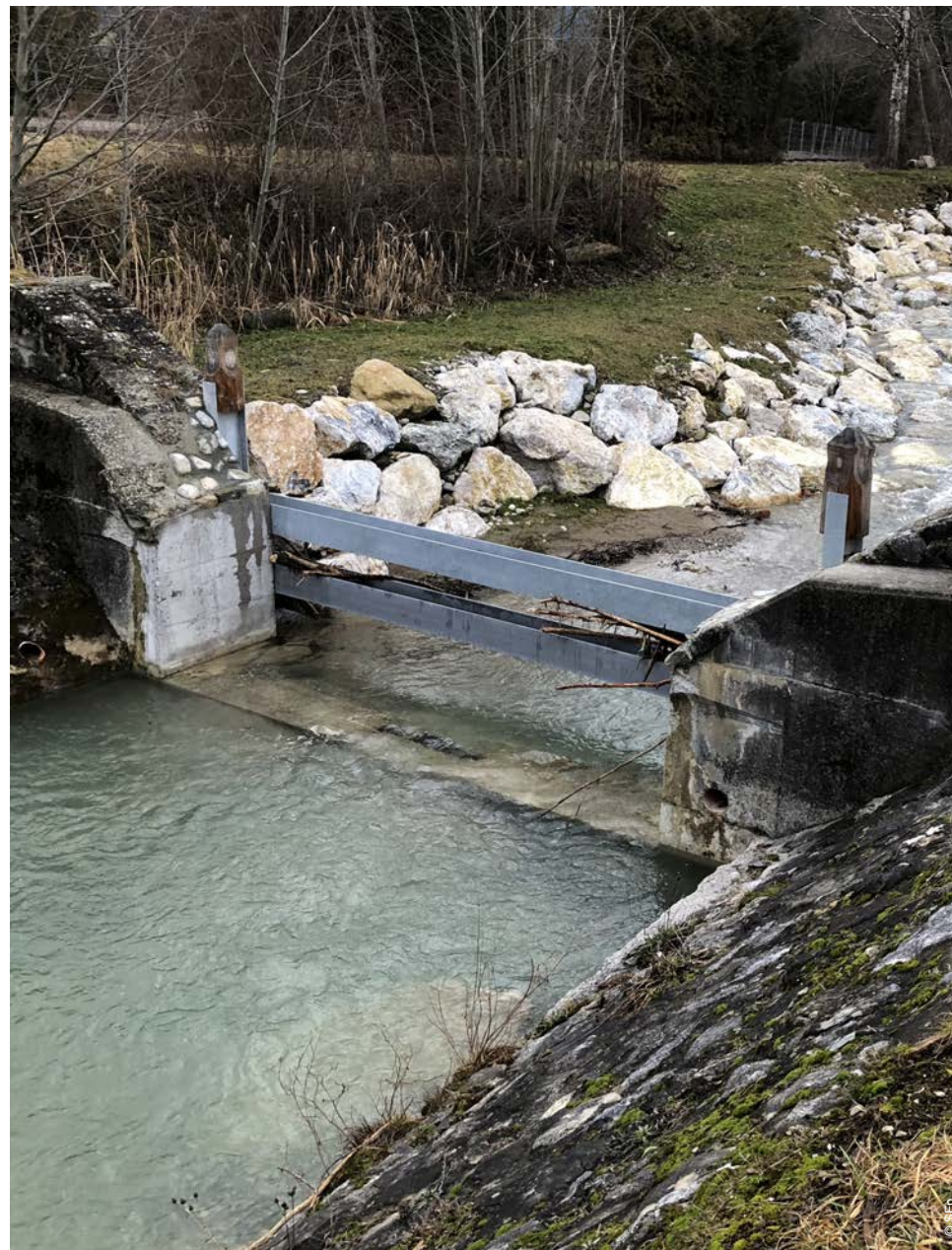
Après les travaux, les poissons peuvent migrer. La herse retient les matériaux en cas de crues.
