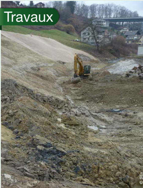
Début des travaux en hiver 2011. Un nouveau lit est créé pour contourner l'agglomération.
