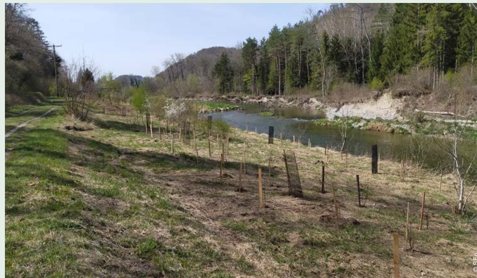
Travaux de végétalisation en 2022. Plantation d'arbustes et d'arbres indigènes dans les zones défrichées temporairement et sur des secteurs favorisant l'ombrage du cours d'eau.
