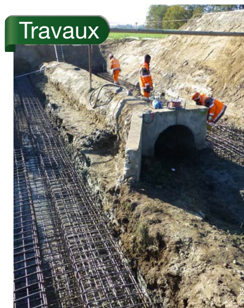
Mise en place d'une demi-buse permettant à la faune de transiter via le cours d'eau.
