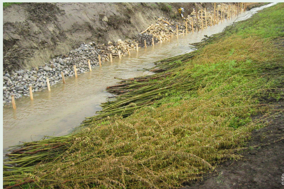
Mise en jauge des saules en vue du repiquage prévu dans les berges.
