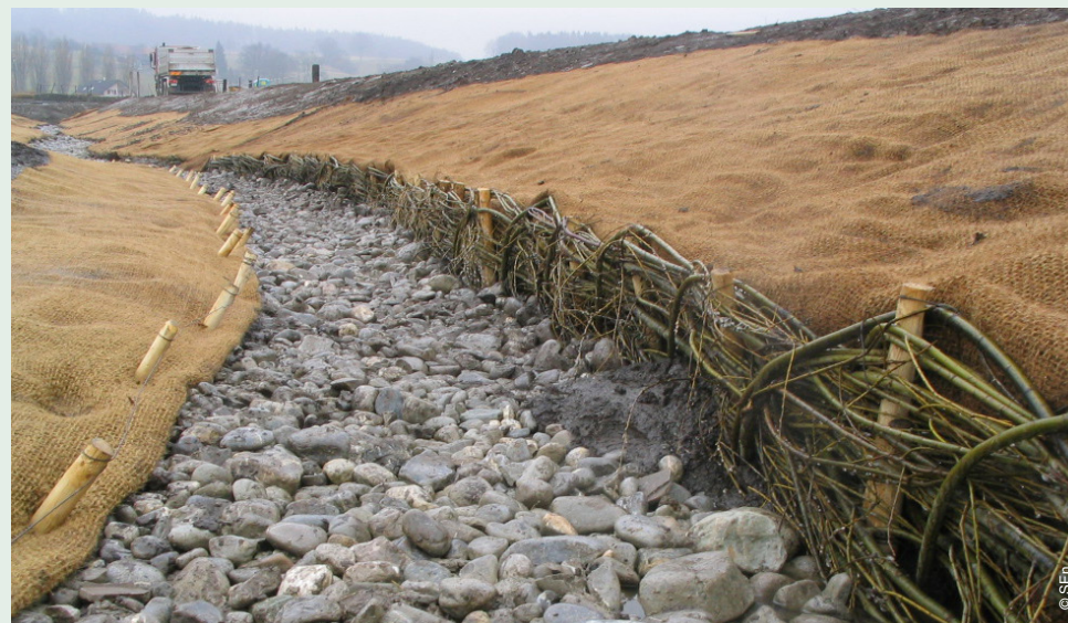
Tressage des saules pour le maintien des berges.
