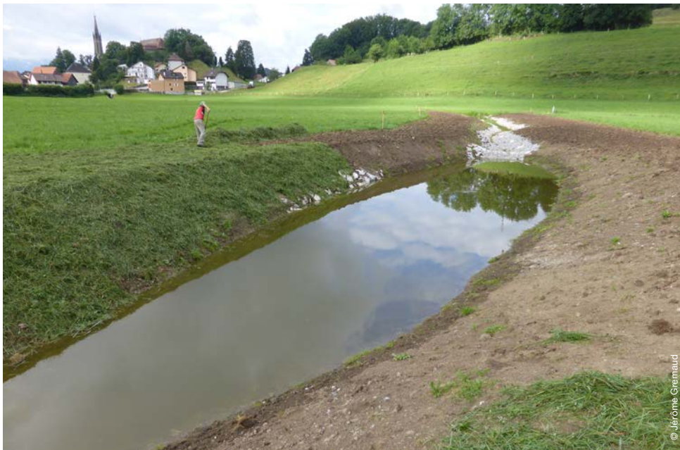
Technique d'enherbement direct.
