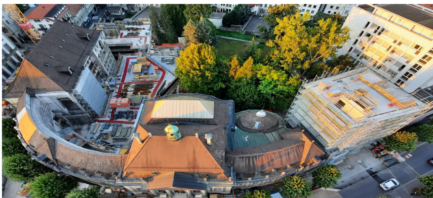
Chantier vu depuis la grue positionnée à la Rue Joseph-Piller. / © BCU et B-O-V Architectes SA
