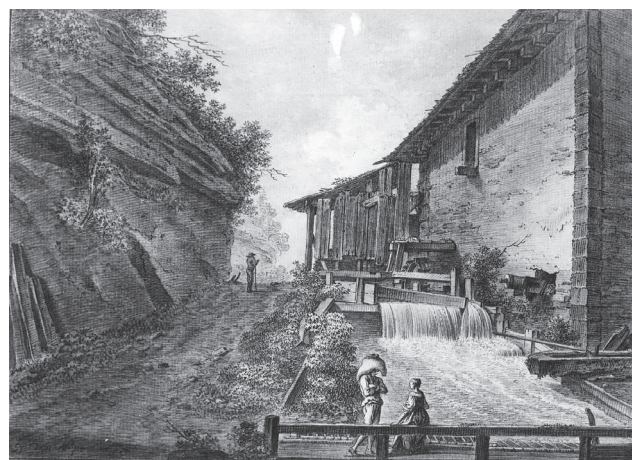
Fig. 6: A gauche: Pilon inférieur à cuivre, devenu moulin à huile au 19 ème siècle (E. Curty, 1805). A droite: Pilon à fer situé non loin de la pisciculture actuelle, une digue dressée dans le cours du Gottéron permettait de dévier ses eaux dans un canal alimentant un grand nombre de moulins (auteur et date inconnus).
