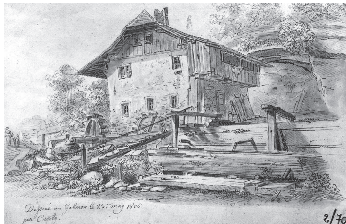
Fig. 6: A gauche: Pilon inférieur à cuivre, devenu moulin à huile au 19 ème siècle (E. Curty, 1805). A droite: Pilon à fer situé non loin de la pisciculture actuelle, une digue dressée dans le cours du Gottéron permettait de dévier ses eaux dans un canal alimentant un grand nombre de moulins (auteur et date inconnus).
