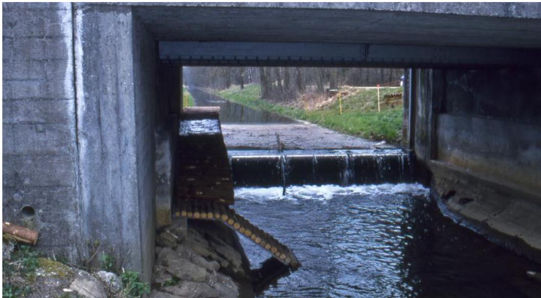
**Bild 7:** Diese 40 cm hohe Schwelle am Hauptkanal im Seeland war für den Biber unüberwindbar. Fünf Biber wurden oberhalb des Tunnels auf der Strasse überfahren. Nach der Installation der links auf dem Bild sichtbaren Rampe, kam es zu keinen Unfällen mehr (Angst 2009).
