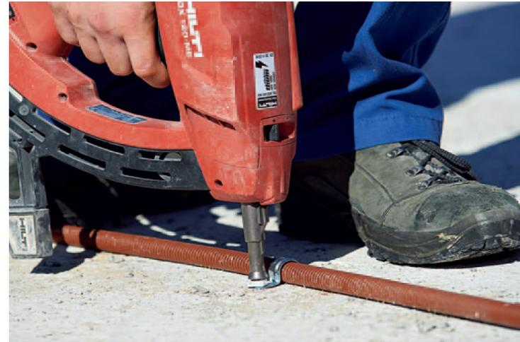
.... verlegen im Rohbau mit modernen Werkzeugen Rohre.
