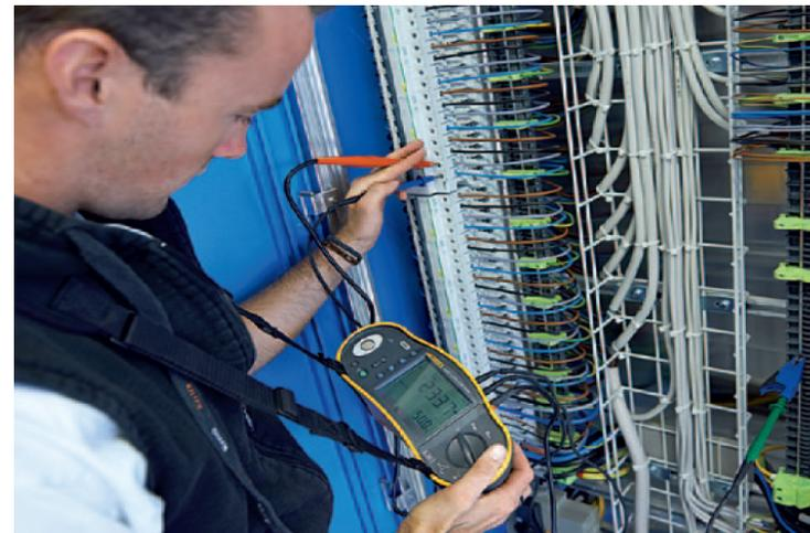
... überprüfen mit Messungen die Sicherheit der Anlage.
