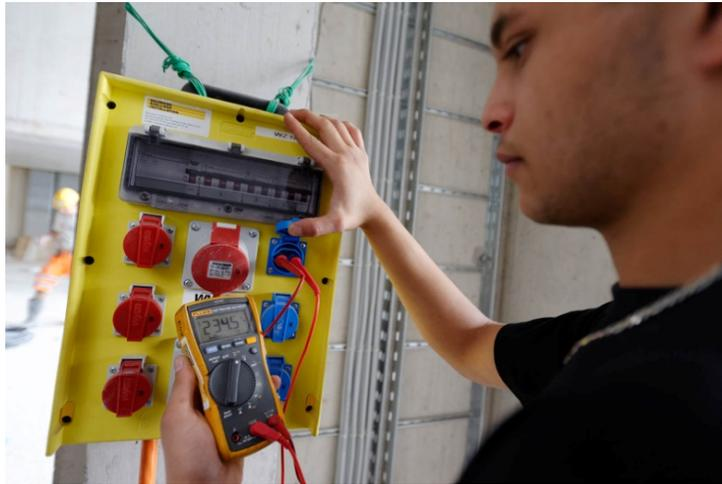
.... messen die Spannung am Baustromverteiler.
