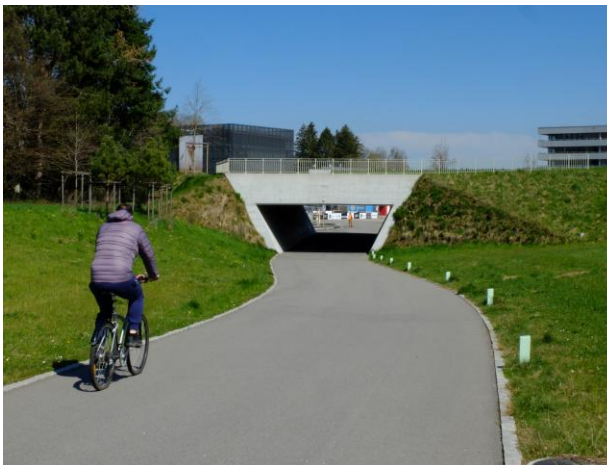
Unterführung unter einer Kantonsstrasse [9]
