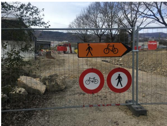
Signalisation bei Bauarbeiten [13]
