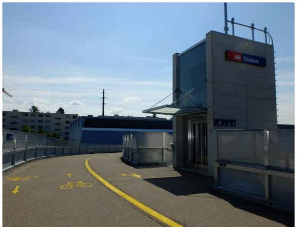
Brücke über Eisenbahnschienen [10]
